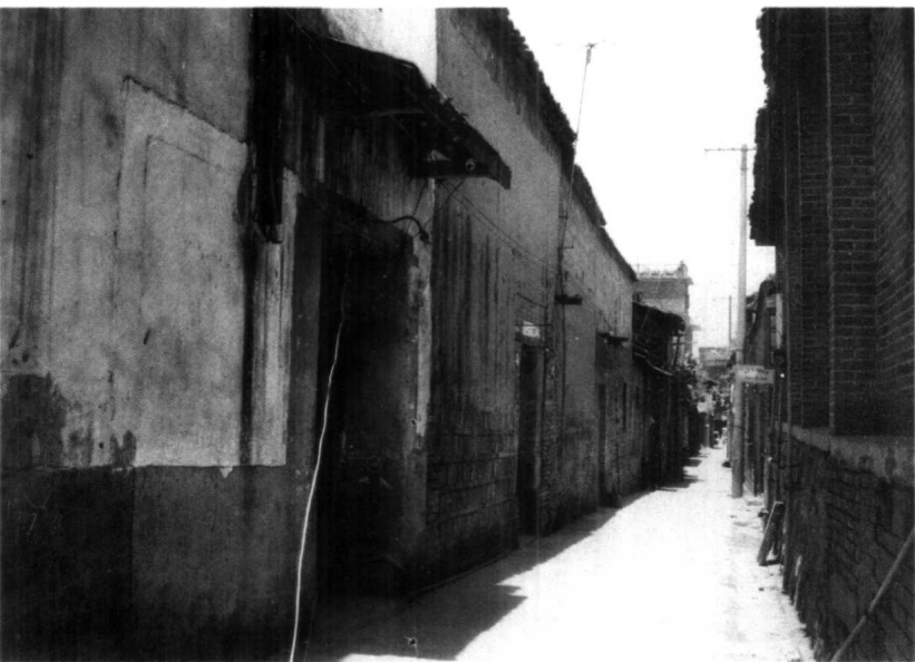
中共建瓯支部旧址：大甲巷7号
