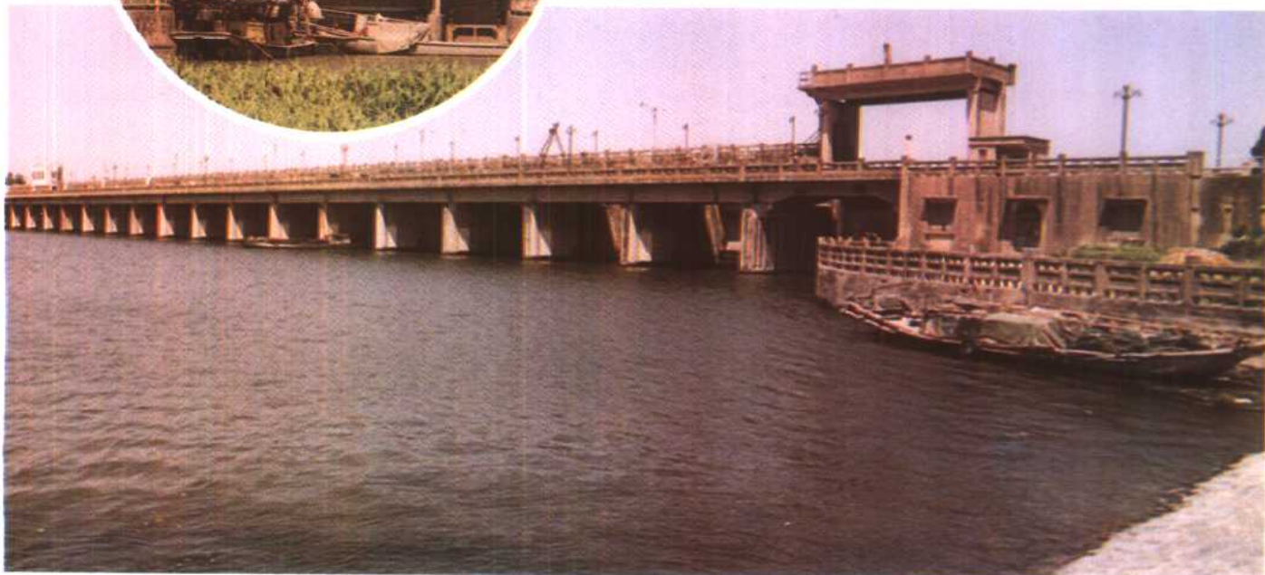
▼ 沿海挡潮大门——射阳河闸
