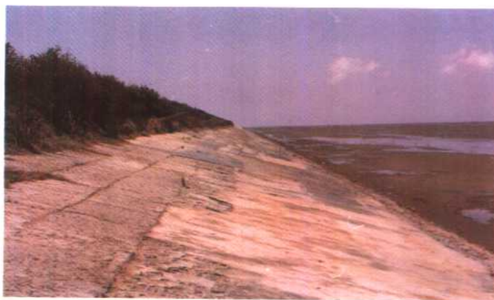
▲ 混凝土护坡
