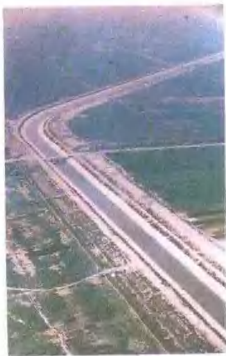
山东跨流域调水工程——引黄济青输水河
