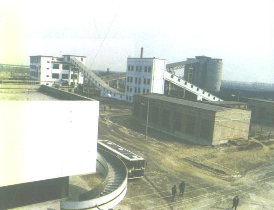
建设中的市洗煤厂
