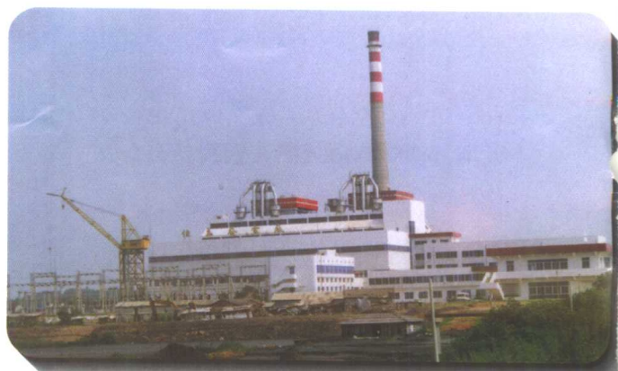
1995年10月16日，中外合资恒益发电厂1号机组投产，为三水市提供充裕的电力。图为厂区全景。
