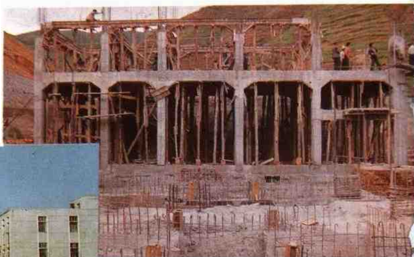
△建设中的错初电站
