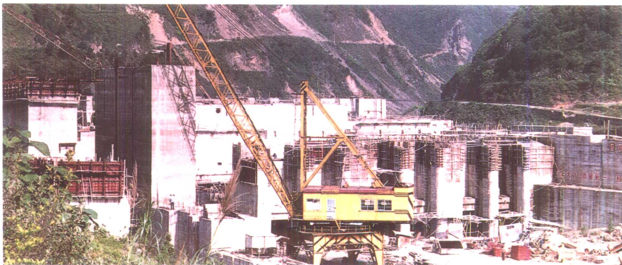
正在施工的昭平水电站 ▲
