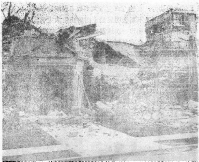
1933年3月10日发生在加州长滩的6.3级地震毁坏了许多校舍，如照片所示的这所中学。这次地震发生在一个星期五下午的晚些时候，学校里没有学生，而在别的建筑物里死亡了大约200人。这次地震标志着美国地震工程研究的开始。
