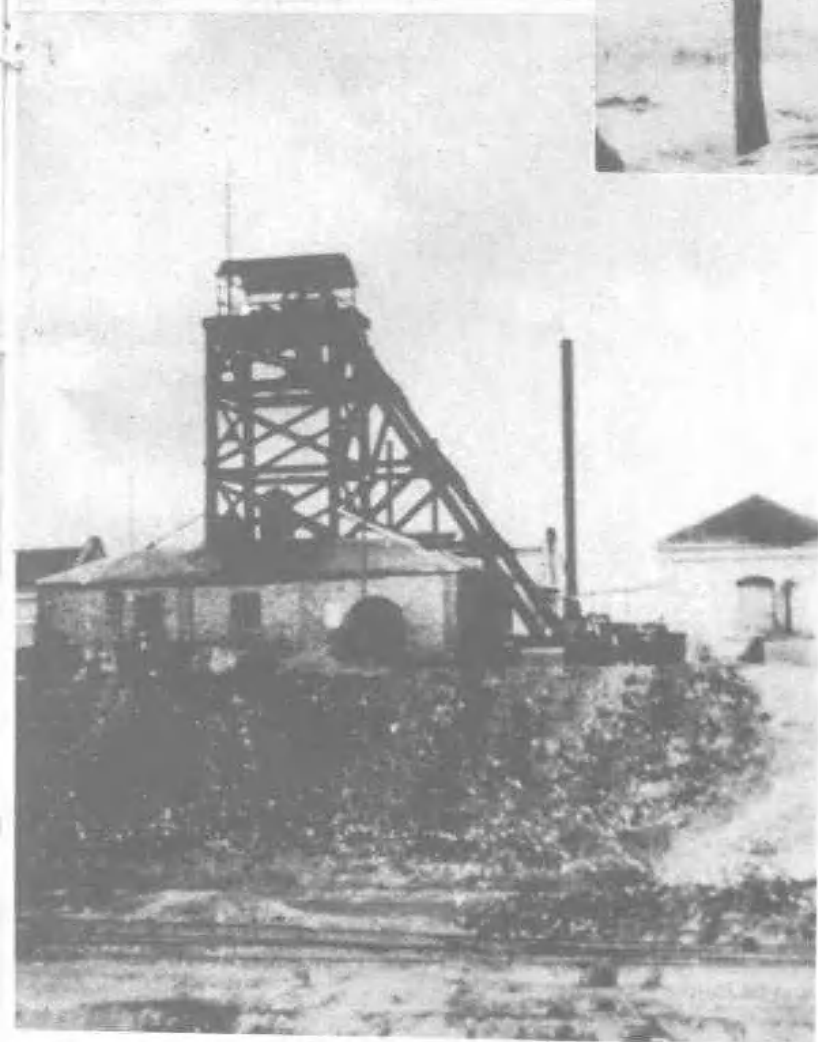
九龙岗东矿一号立井 (1930年)。
