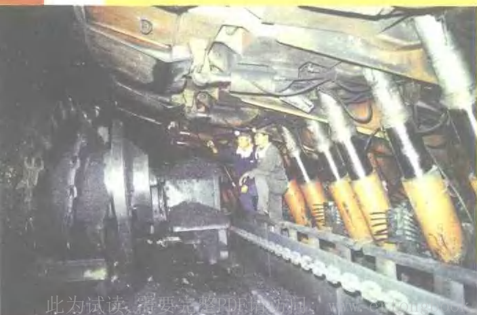
安徽省地方煤矿第一套 综采机组在百善煤矿投入生 产,这是综采工作面。
