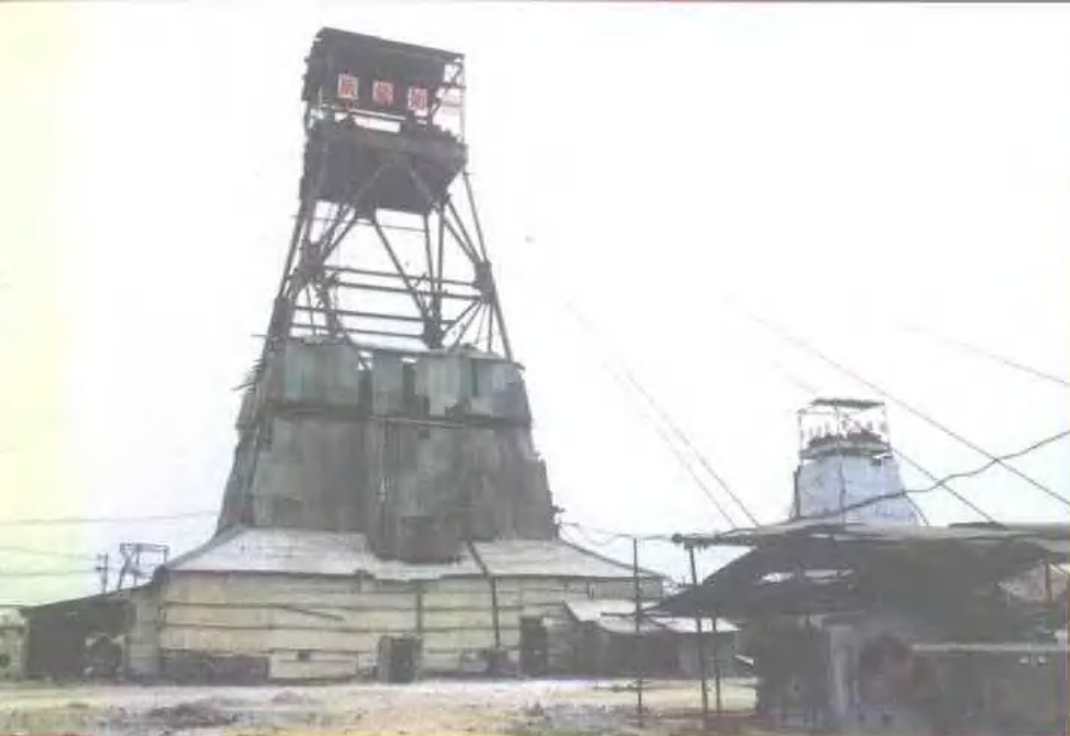
安徽省地方煤矿中最大井型、设计生产能力 150 万吨的皖北任楼煤矿在加快建设 中。
