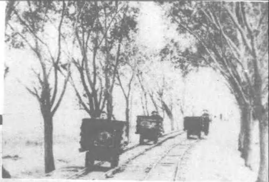
烈山煤矿运煤车道(1929年)。
