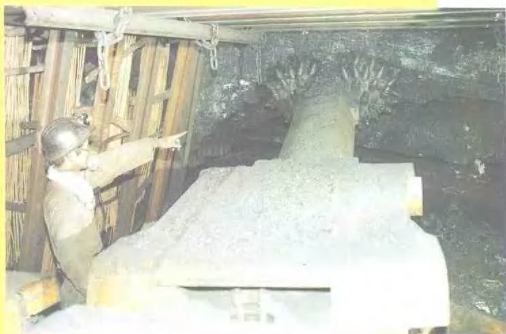
淮北矿务局朔里煤矿综 掘工作面。
