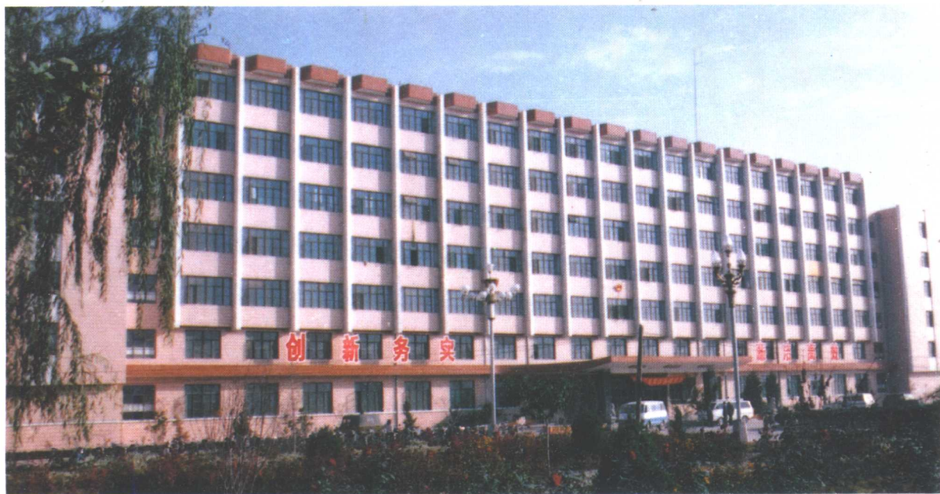
市政府办公楼
