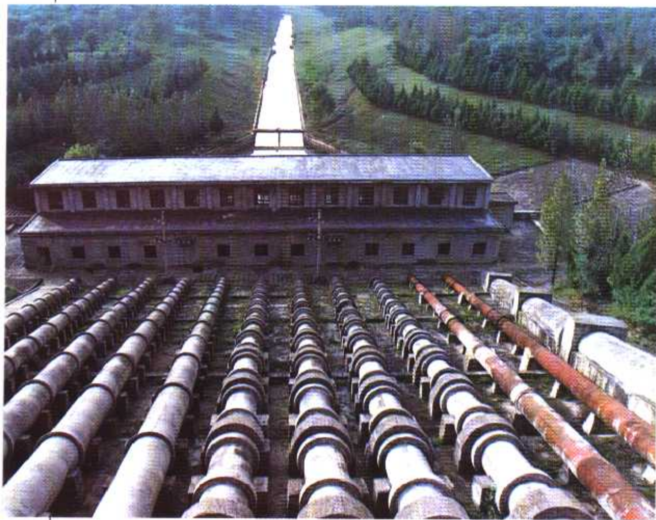
大岗坡二级提水站
