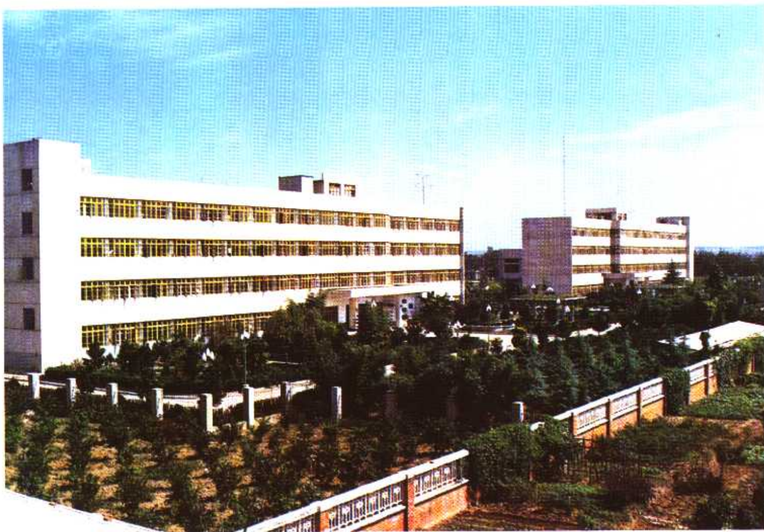
市委市政府办公楼
