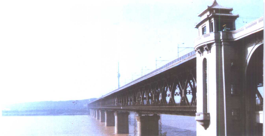
武汉长江 大桥
