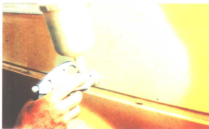
4. 用重力喷枪喷涂面层涂料与填料的混合物
