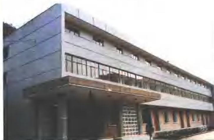
图 60. 电子工业部第 26 研究所超净实验室
