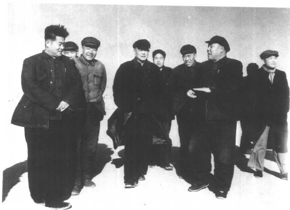
李先念副总理视察淦阳新河工地（1967年）
