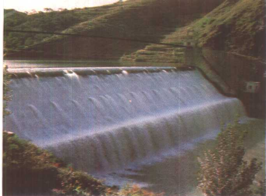
兴隆县老虎沟水库
