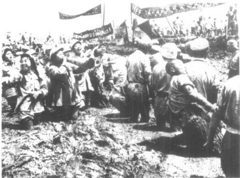
新中国第一个大型水力工程荆江分洪工程正在施工之中。
