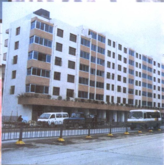
▼ 贵阳中天公司在贵开路旁修建一批“安居工程”住房。 (王时)
