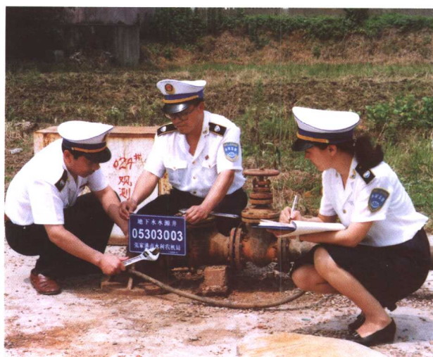
检查取水设施
