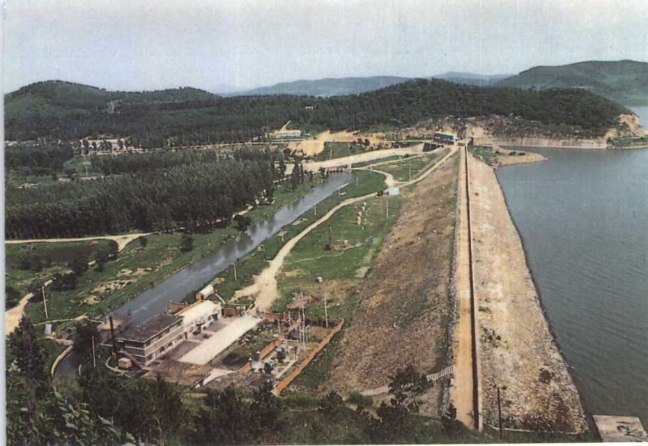
石头门水库大坝
