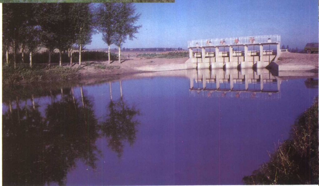
扶余引拉(拉林河) 工程渠首闸
