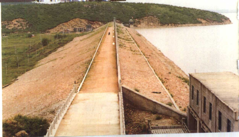
舒兰县亮甲山水库大坝
