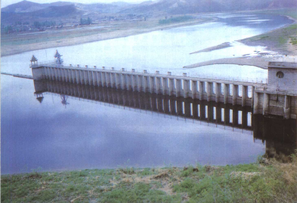
通化县东江水轮泵站
