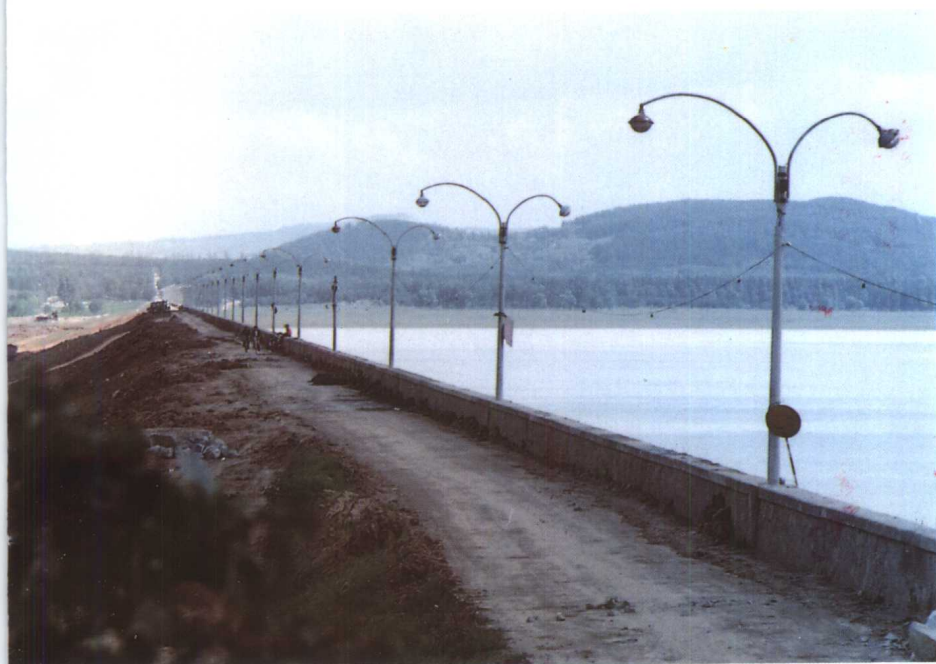
正在除险加固的新立城水库
