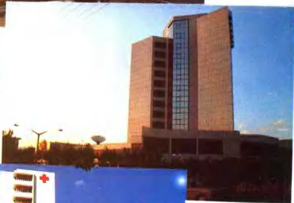
玉溪地区医院住院大楼
