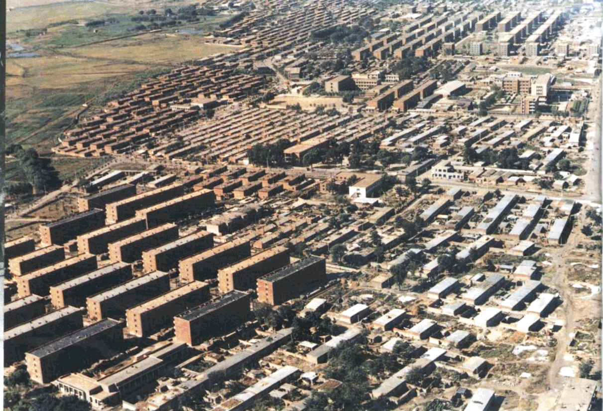
震後復建的居民住宅樓
