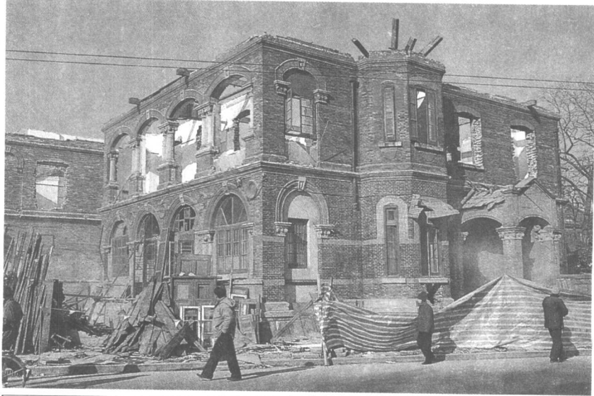
上海在拆除中的老房子
