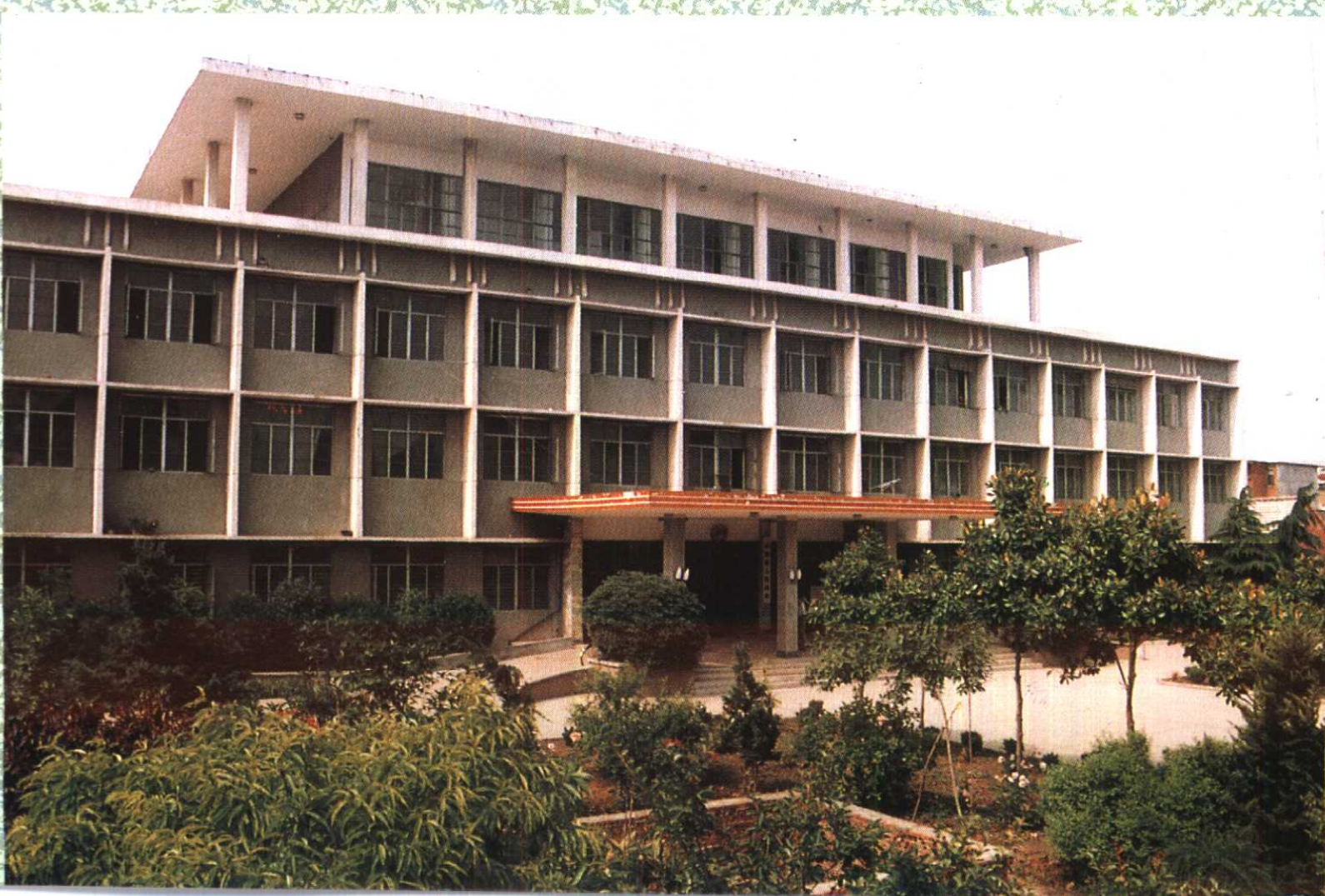
县人民政府办公楼
