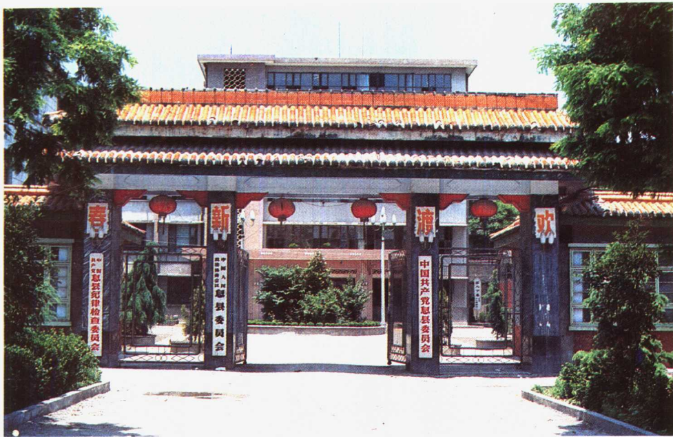
县委、县政协办公大楼
