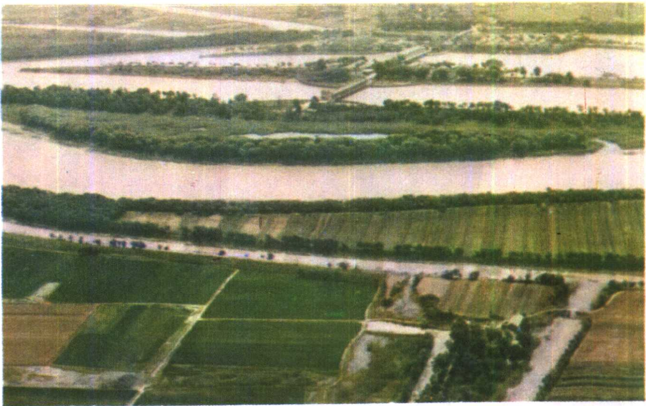
苏北灌溉总渠水利工程
