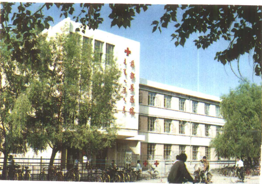
县医院门诊楼
