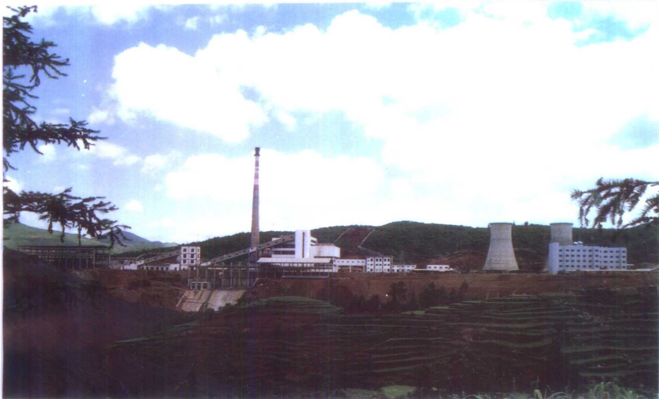
工商银行扶持的贵州 盘江电力股份有限公司老 屋基煤矸石发电厂
