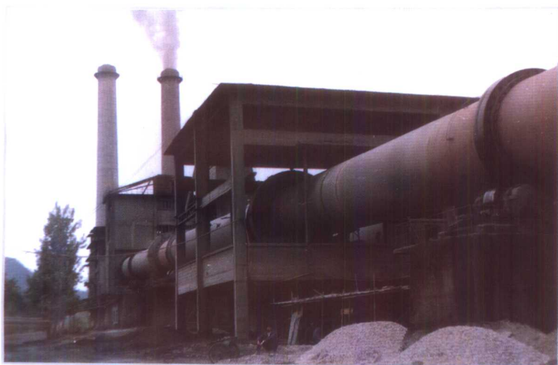
市建行支持建成的年 产 50 万吨水泥的水城水泥 厂
