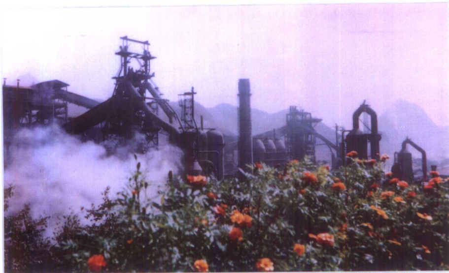
市建行支持建成的水城钢铁公司炼铁厂
