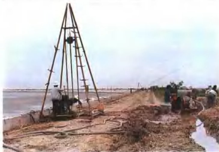
省水利科研所的土坝 坝体劈裂灌浆技术成果获 1985年国家科技进步二等 奖
