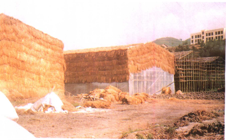
塑料棚架式菇房的建造过程
