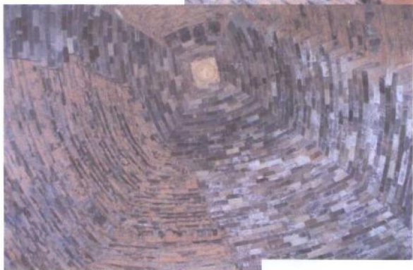
孝文帝虚宫四角攒尖式墓室 顶部（顶部中央嵌一块雕有莲花 纹图案的白石）
