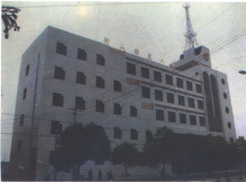
◁ 城关建筑公司承建的衡山邮电大楼被评为省优样板工程
