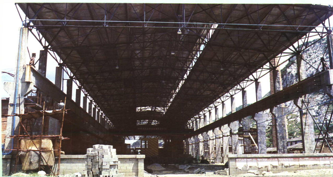
贵州省冶金建设公司承建的 650 工程
