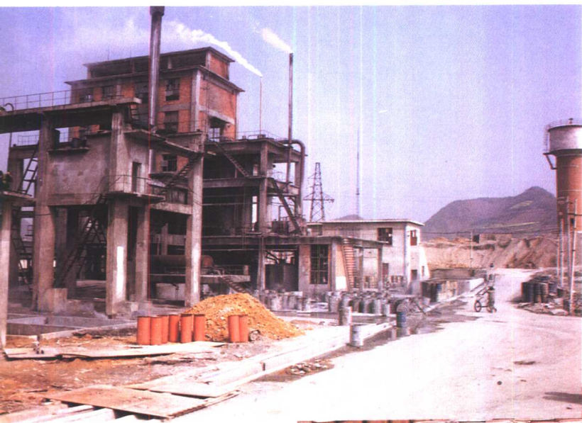
金沙黄磷厂厂区一角
