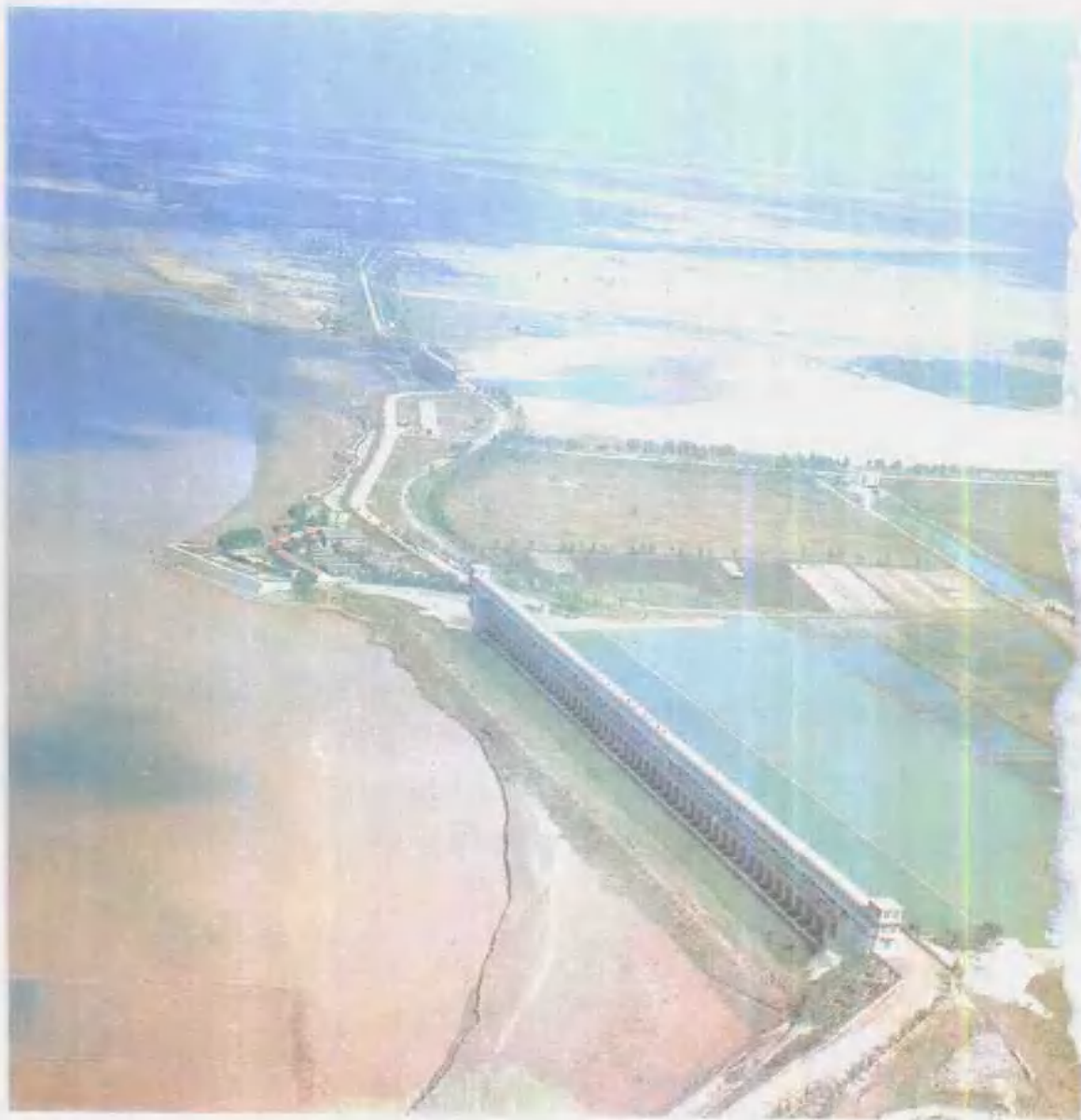
洞庭湖水控制工程
