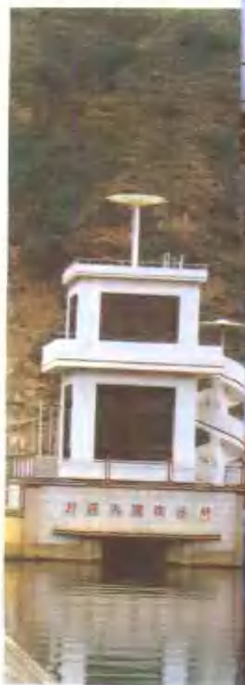
• 引洱入宾进水闸
