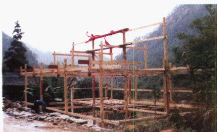
刚举行过上梁仪式的新屋架
