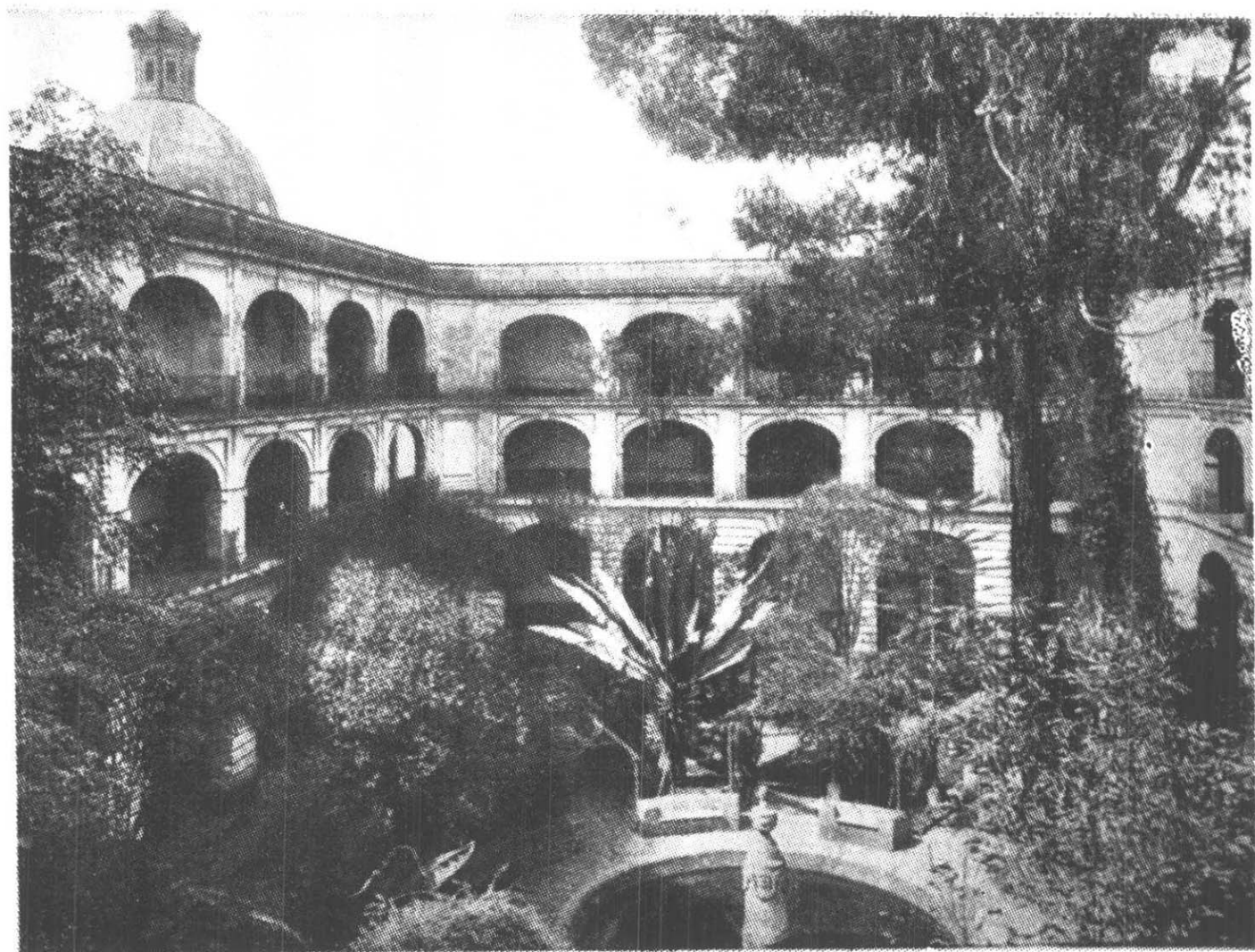
努埃斯特拉·塞尼奥拉·德·拉·恩卡纳西翁修道院 的庭院，西班牙文艺复兴建筑风格之代表作。
