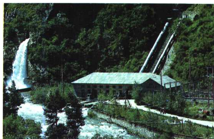
四川康定县龙洞沟小水电站
