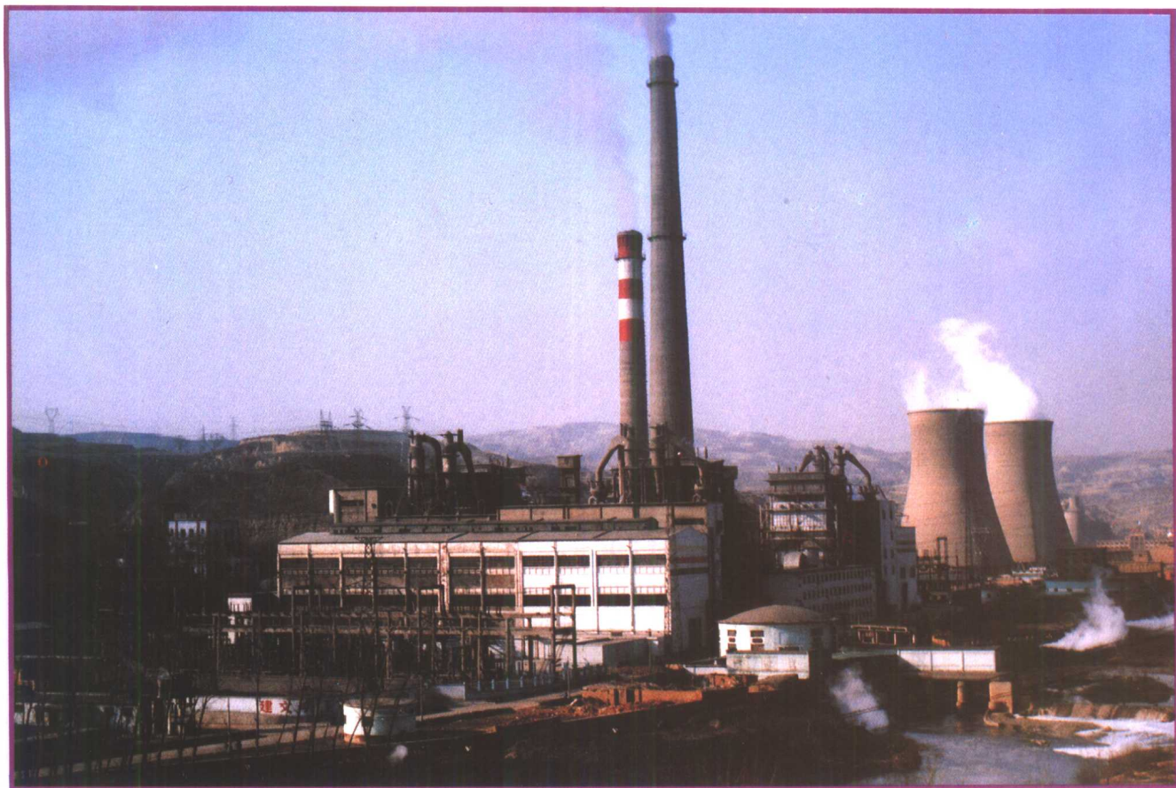
霍州发电厂厂景 生活区一角
