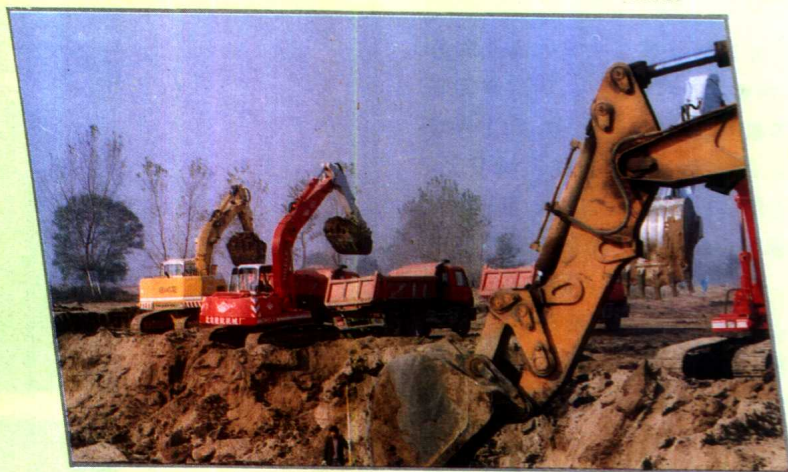
凉水河治理工程
