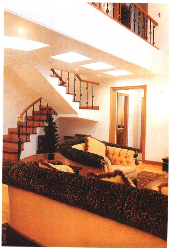
3、4. 楼梯做曲线设计, 造型轻巧灵活, 木地板铺面, 铁艺花饰护栏。
