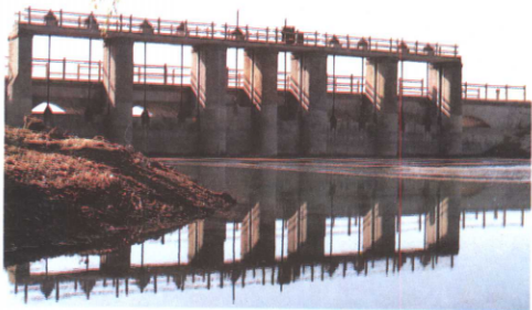
大清河马庄拦河闸工程
