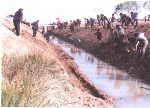
雄县农村水利建设现场
