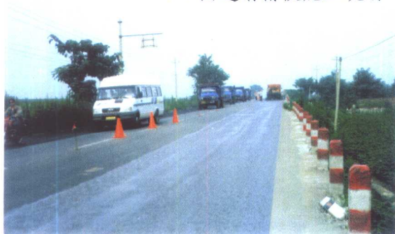
310国道渭南段施工现场
