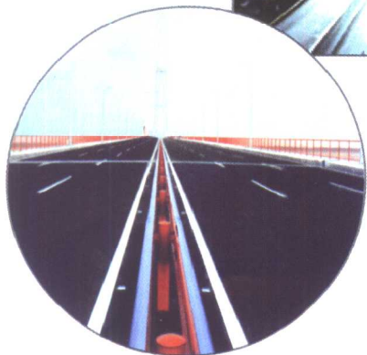
科氏改性乳化沥青粘层铺设的大桥
