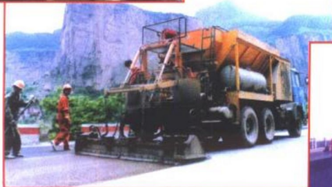
▲ 新乡—陵川山区公路施工
