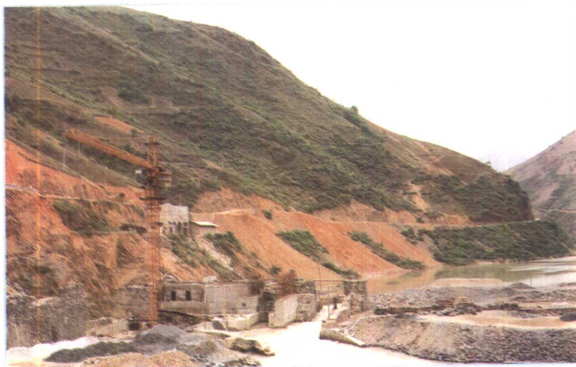
兴建中的雷公滩电站
