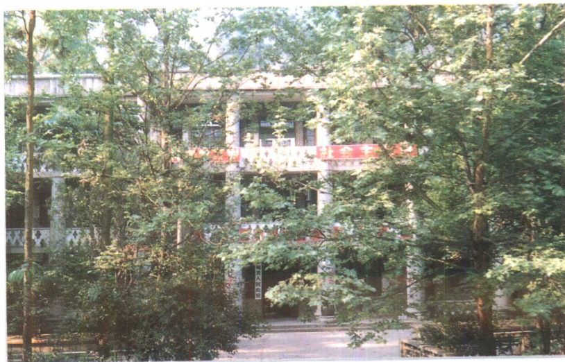
县人民政府办公楼
