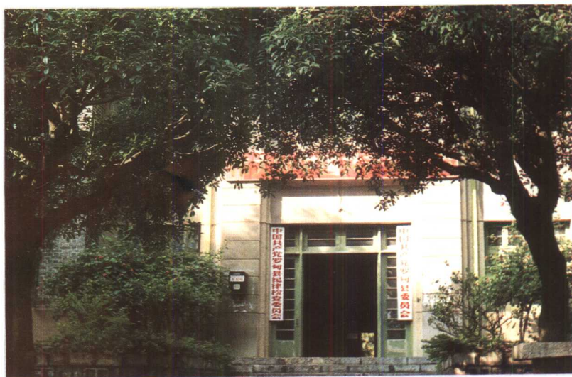
中共罗甸县委办公楼
