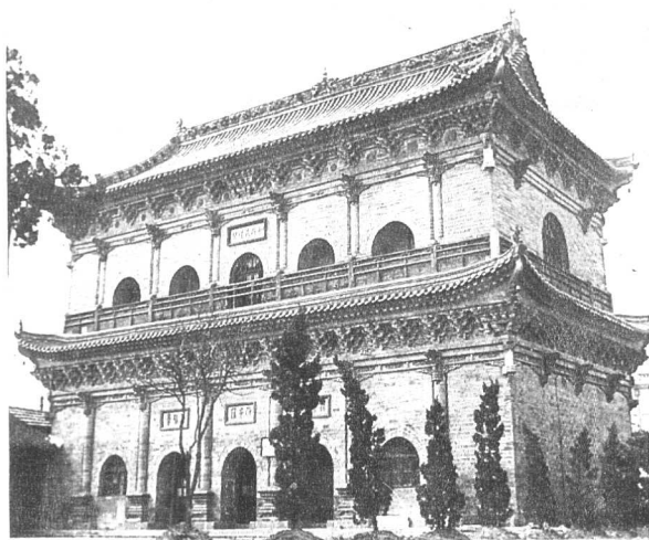
蘇州開元寺無梁殿
