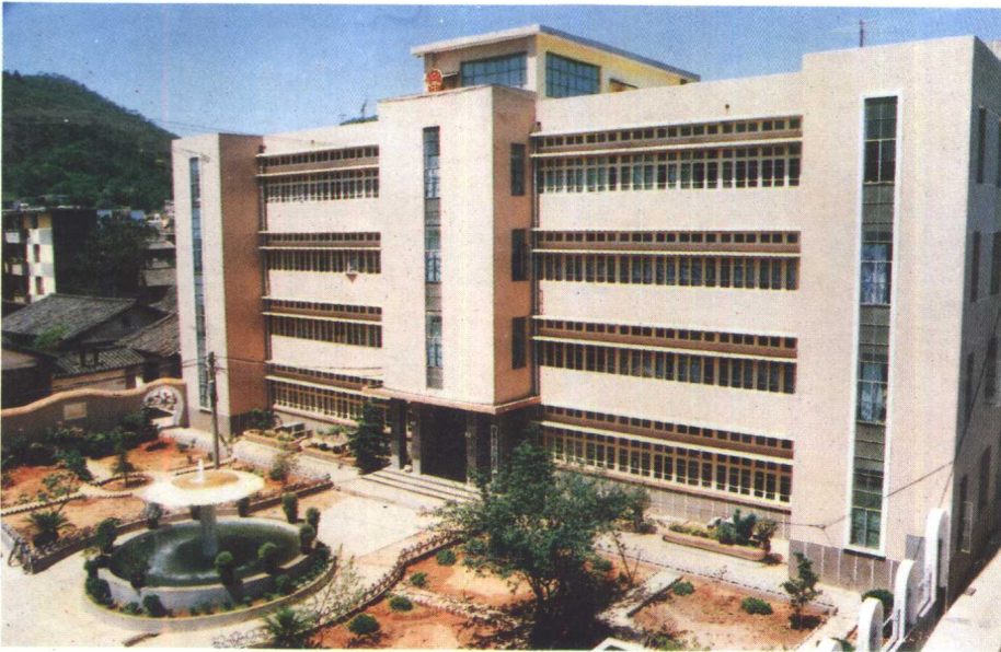
通海县人民政府办公大楼
