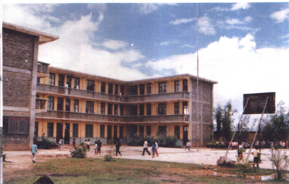
镇海小学新建 教学楼（左） 原校舍（下）
