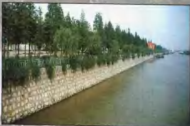
东横河市区段驳岸及绿化工程
