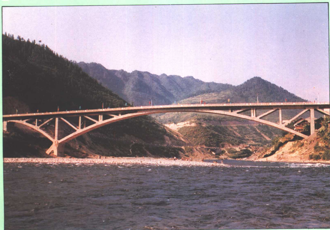
贵州创建的 预应力桁式 组合拱桥主 跨 150 米的 剑河桥
