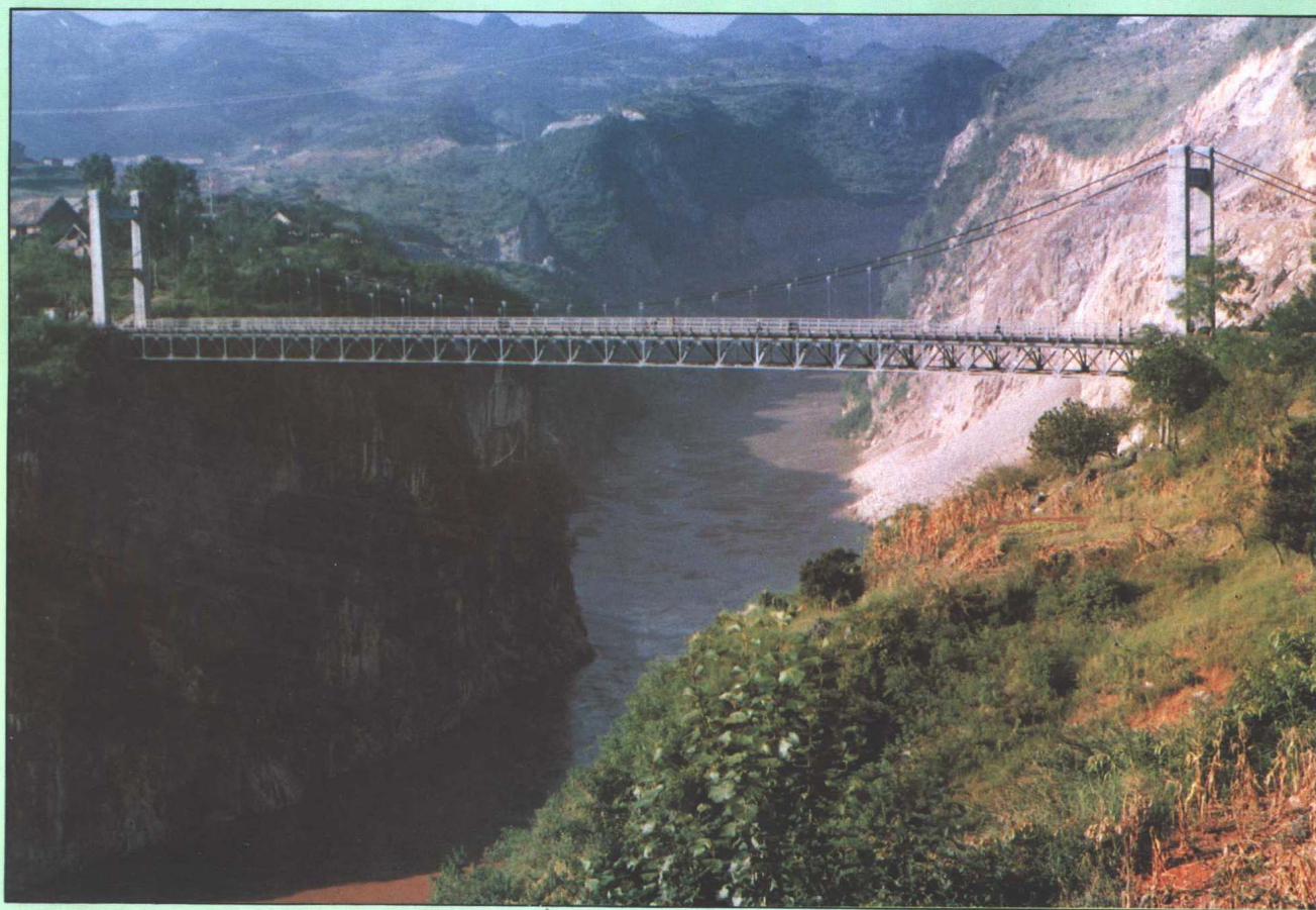
清毕公路上的鸭池河吊桥
