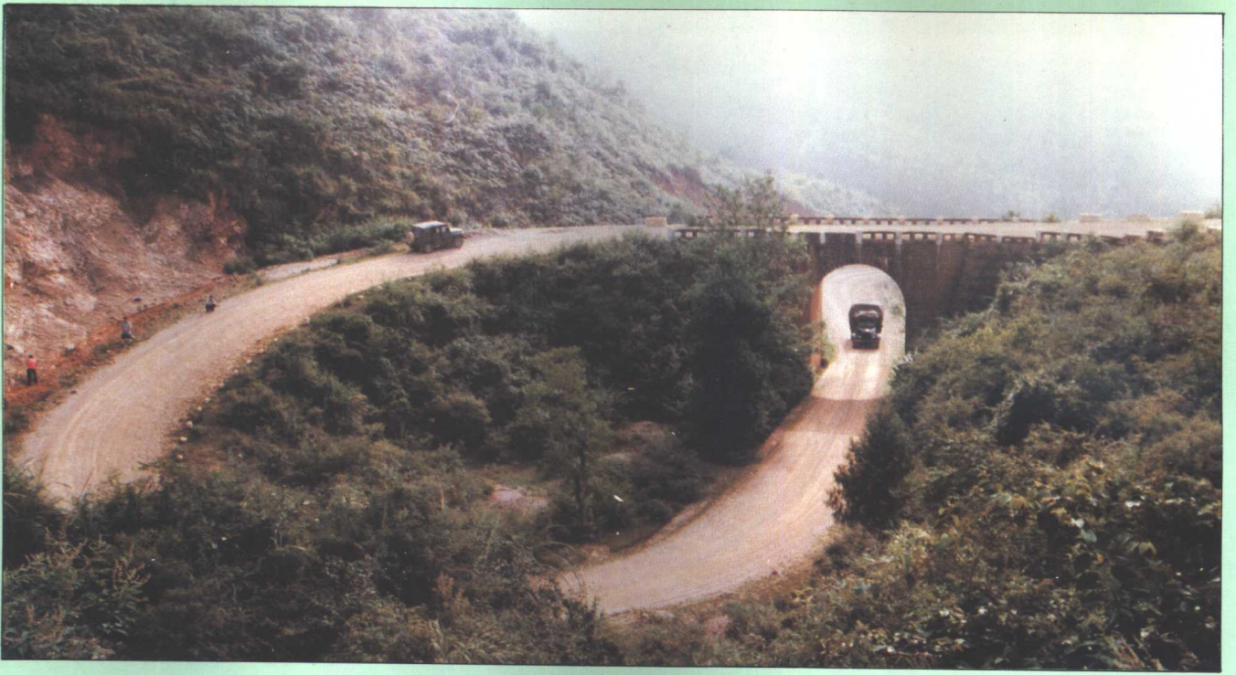
湘黔公路上的“鹅翅膀”回头弯上下线
