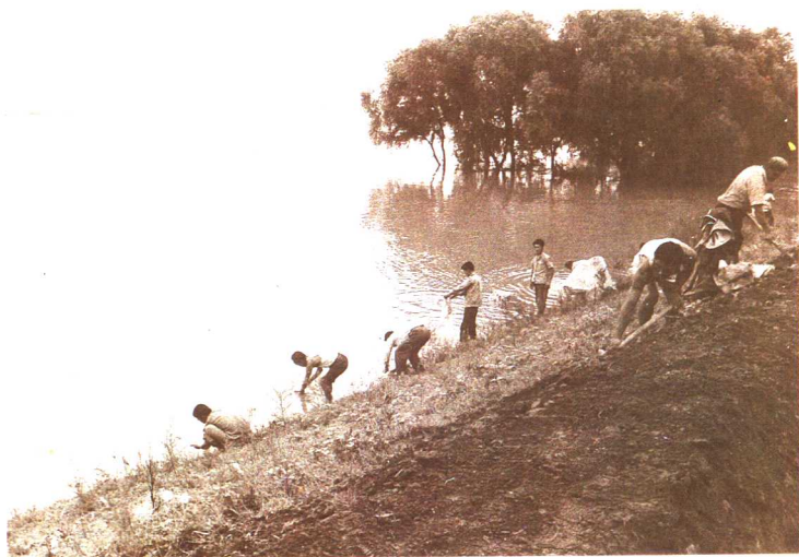
台安县民工抢修堤坝
