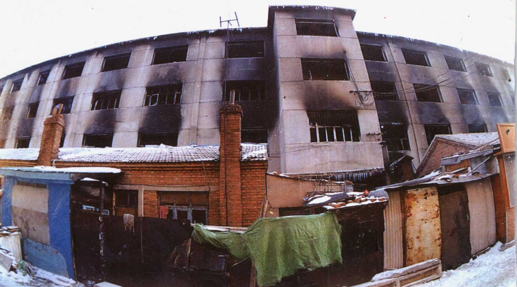
被烧毁的商场外景
